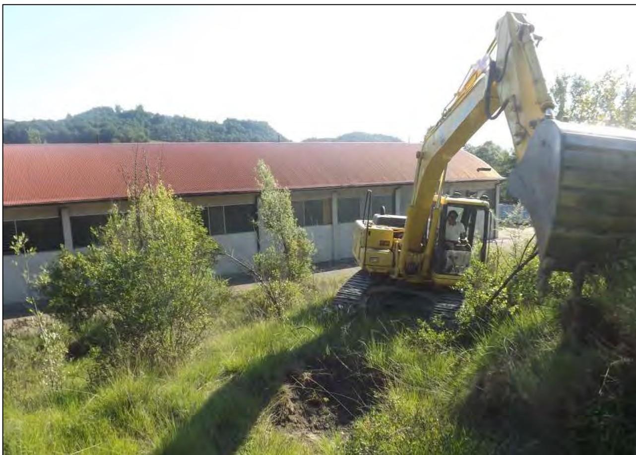
Foto n° 3 – esecuzione sondaggi con escavatore
