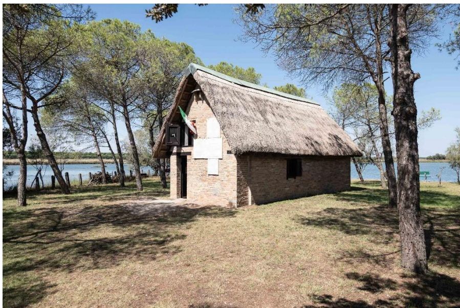
Loc. Baiona, Ravenna (RA), Capanno Garibaldi (foto Luca Bacciocchi 2021-2022)
